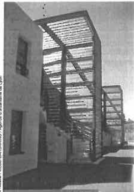
Opération Beaumanière (Dardilly), un exemple d'habitat individuel dense.
